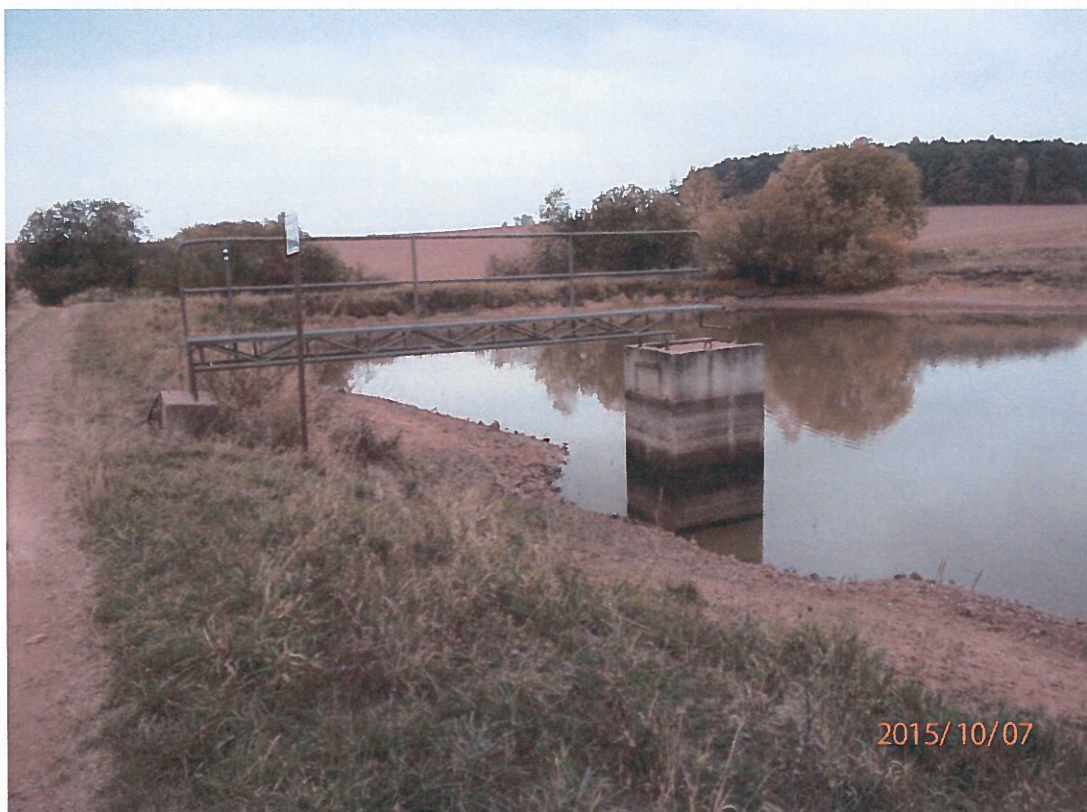
Stávající výpustné zařízení s přístupovou lávkou
